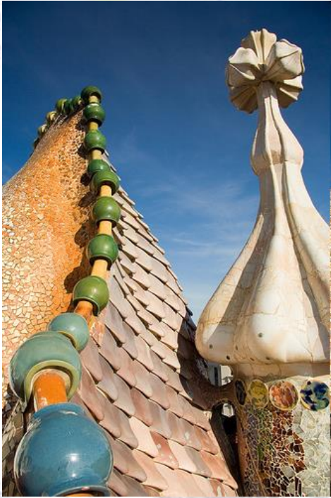
Tejado Casa Batlló. Gaudí. 1904-1906.
