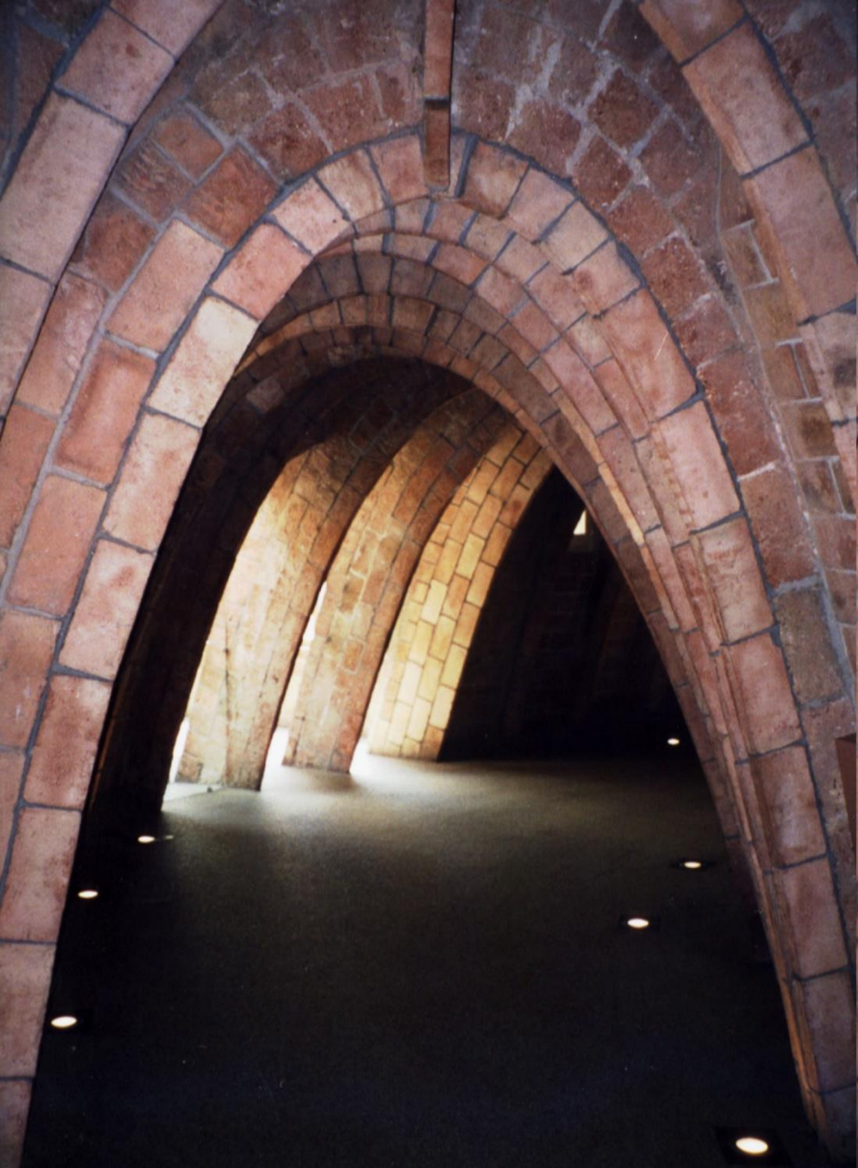
Casa Milá (La Pedrera). Detalle del desván. 1906-1910.
