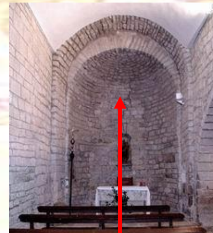
Bóveda de cuarto de esfera.
