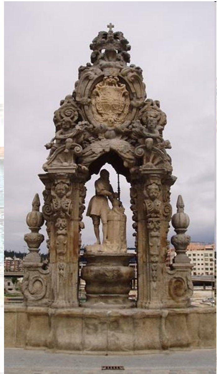
Hornacinas del Puente de Toledo. Madrid. 1718-1732.
