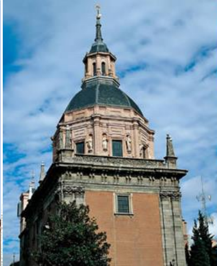
Pedro de la Torre. Capilla de San Isidro. Madrid. 1653.
